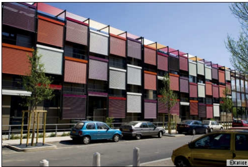
La façade équipée de ses brises soleil
